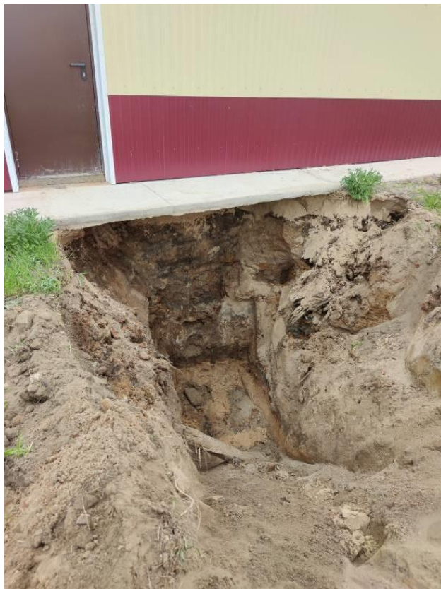
Фото №39. Шурф №1 в осях «В» / «7».
