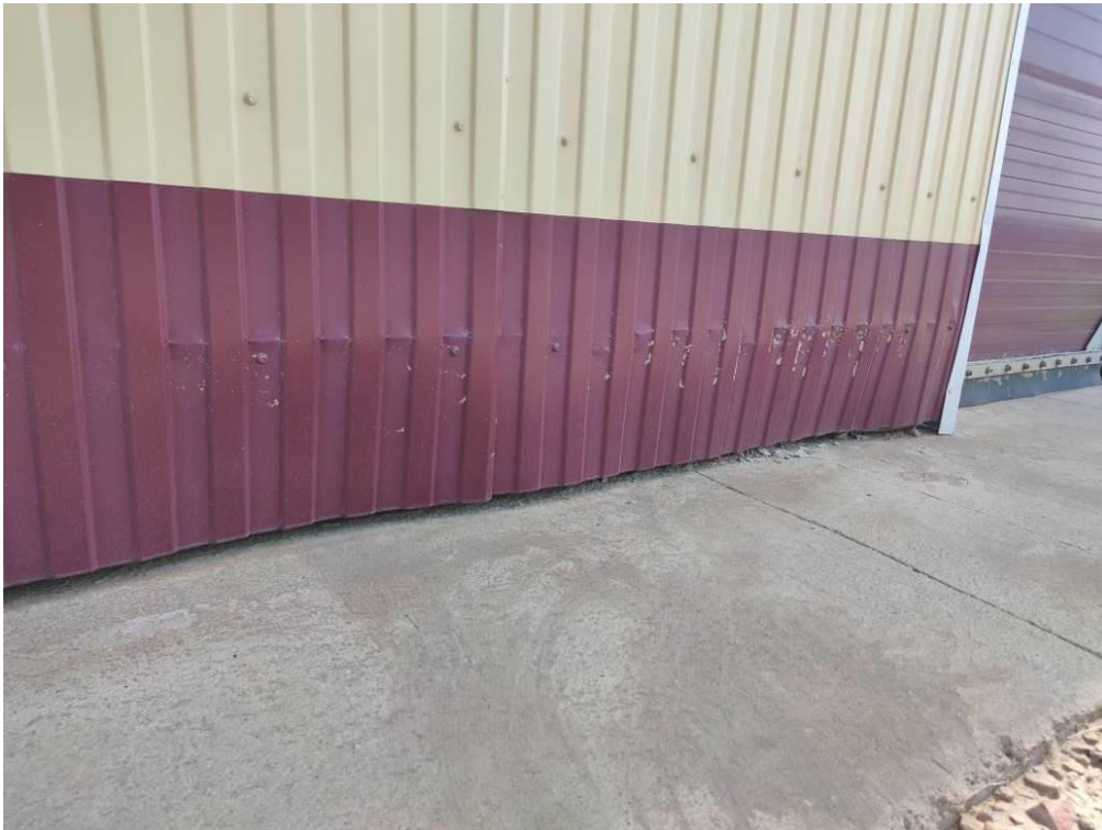
Фото №2. Участок фасада в осях «2-3». Механическое повреждение (замятие) обшивки фасада (профилированного листа).
